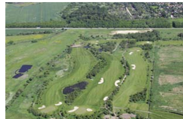
Fig. 16. Golfbanen set fra vest. Den lavest beliggende del af Golfbanen risikerer at blive sat under vand ved den forventede havstigning, der kan tvinge den til flytning. Det kan derfor være klogt at planlægge flytning nu. De dele, der bliver oversvømmet, vil blive til våde enge, der kan få et rigt liv og sikre Nørrestrand.
