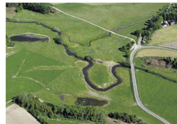
Fig. 18. Bygholm Å er genslynget ved Kørup. Før var åen en kanal; rester af den ses tværs over slyngningen og til højre for vejen. Se fig. 21.
