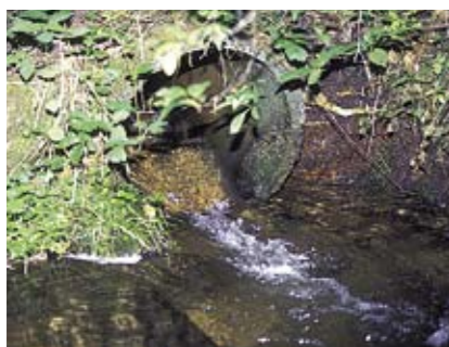
Fig. 26. Udmundning af rørlagt bæk. Ørreden svømmer nædigt gennem et sådan rør, der virker som spærring. 1997.
